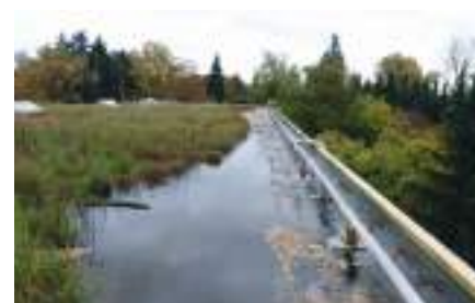
Mit einem Retentionsdach kann das Regenwasser zurückgehalten und verzögert abgegeben werden
