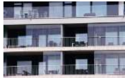
Bauliche Massnahmen (z. B. Loggien) an Gebäuden entlang der Engestrasse
