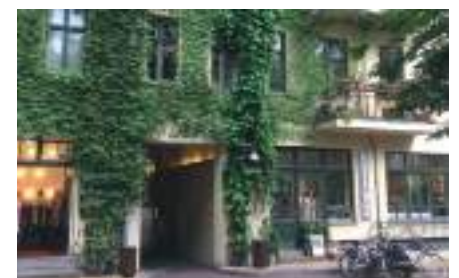
Fassadenbegrünungen, Strassenbäume und unterschiedlich genutzte Vorzonen bieten ein attraktives Quartierbild
